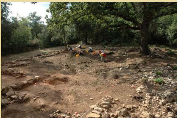
Lo scavo sul sito della "Casa delle Anfore".
